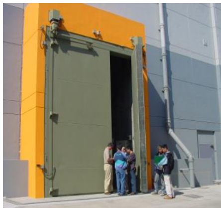
圖 57：隔音門 （蒙 NAP 聲學工程（遠東） 有限公司特許轉載此圖）
