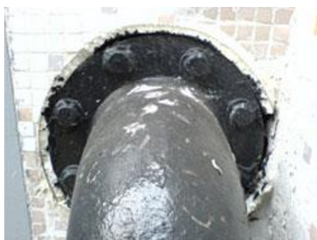
以可壓縮物料包裹 穿透建築物結構的喉管
