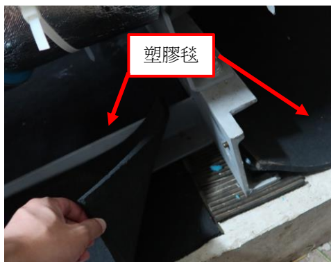
在機器底部和地面蓋上塑膠毯
