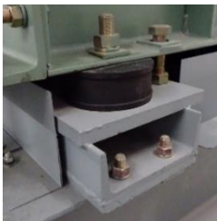
圖 35：用於曳引機械的避震軟墊
