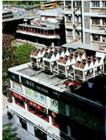
設置排氣口的方向於 遠離噪音感應強的地方
