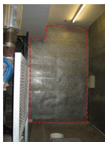
鋪設有吸音物料 的牆壁
